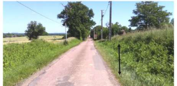
Légère dénivelée qui limitera la perception des pavillons à leur partie haute
