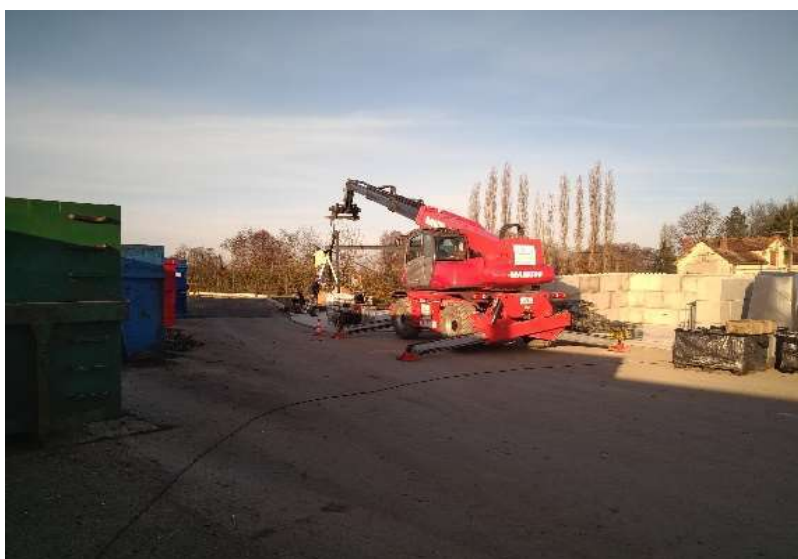
Travaux à la déchetterie de Cercy-la-Tour
