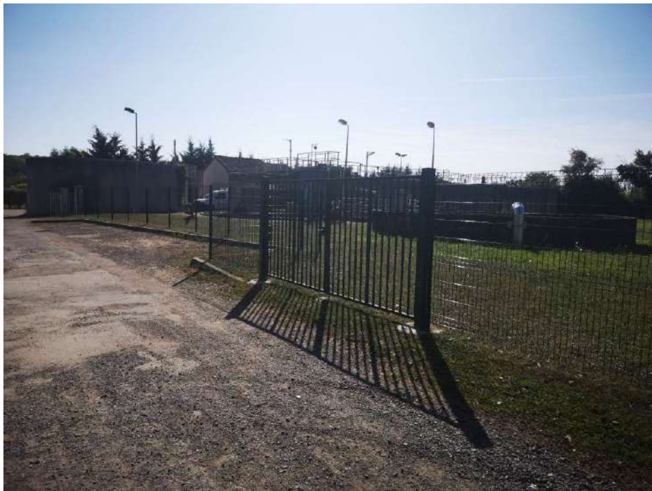
Installation d'un nouveau grillage à la station d'épuration de Saint-Honoré-les-Bains
